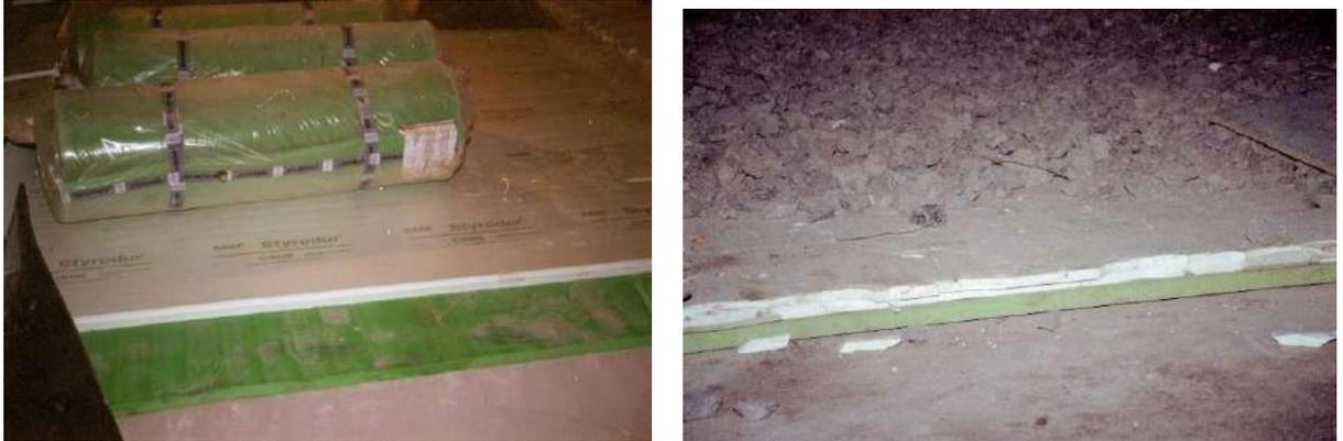
Рисунок 3.2 – Укладка подбалластного мата в Гагаринском тоннеле
