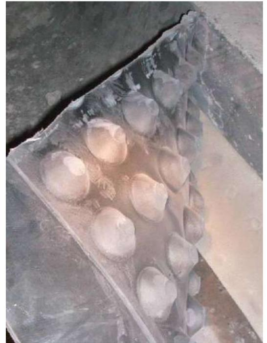
Рисунок 3.7 – Расположение упругого мата между путевым бетоном и обратным сводом тоннеля № 4А
